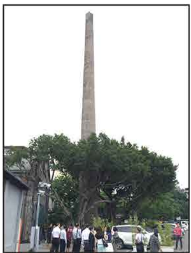
華山的煙囪係配合鍋爐設置，建於1931年酒廠新工場建設時期
