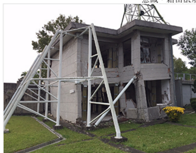
園區內以支架保存傾斜的建築讓觀眾體驗
