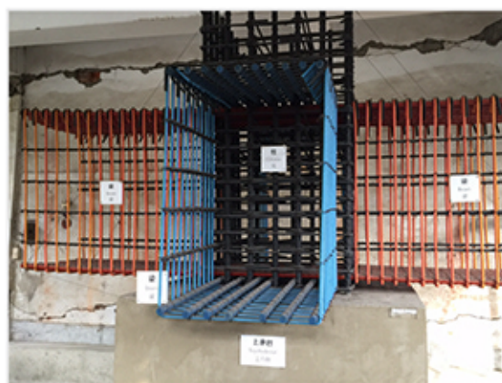
展示現今台灣建築物之樑與柱的鋼筋應有規格
